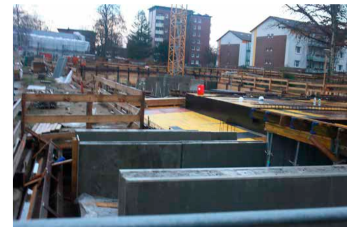
Am Dudenweg gibt es eine große Baugrube für eine Tiefgarage, auf der dann Reihenhäuser neu gebaut werden Foto: Timm
