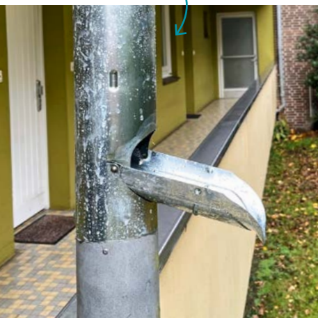
Drainage Entwässerungsklappe an einem Regenfall- rohr
