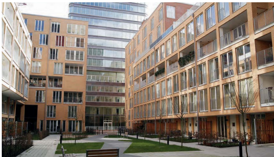
Wohnanlage der HANSA in der Bernhard-Nocht-Straße
